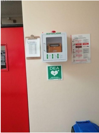
3º piso edificio Antonio Varas
