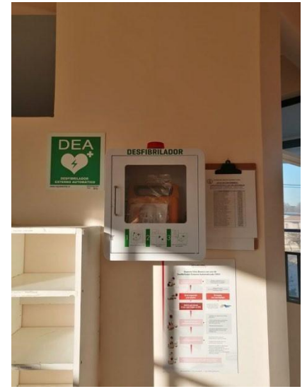
Edificio Madre Paulina 2º piso
